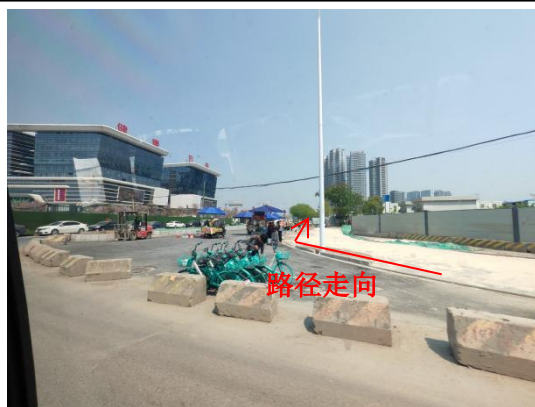
线路沿线(利用翠园路、荔创南路电力隧道)
