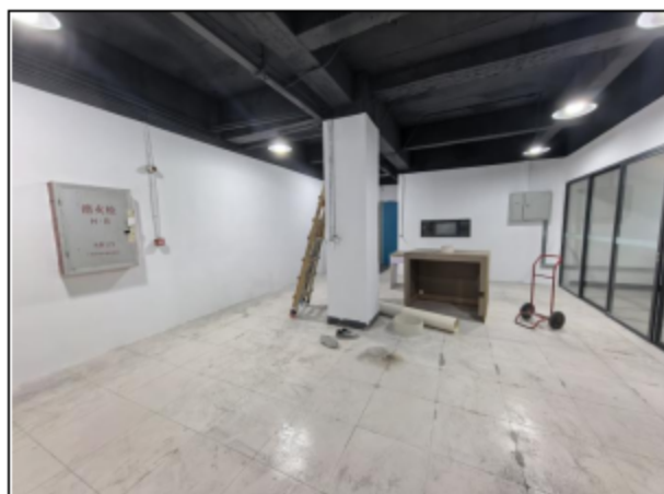
项目内部（二层倒模房）
