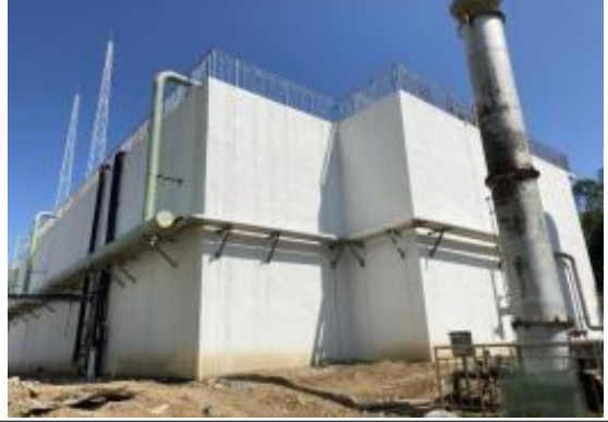
图 3.5-7 电厂二期高浓度处理系统
