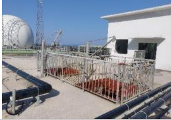
图 3.5-6 电厂二期渗滤液调节池
