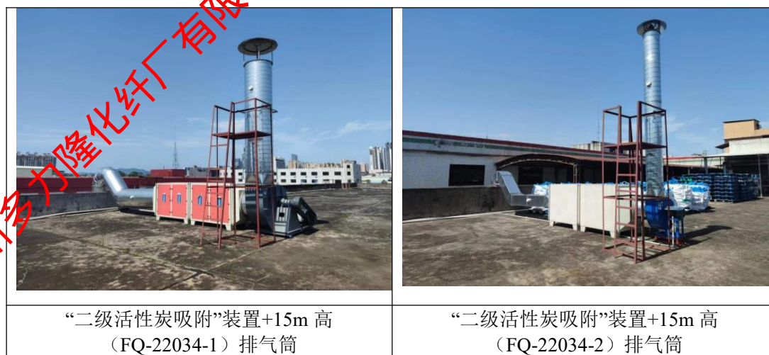
图 2-5 现有项目有机废气收集治理设施现场图
