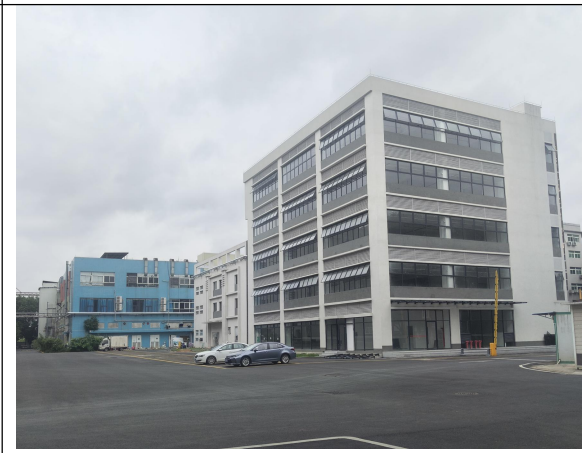
项目南侧：道路、停车场
