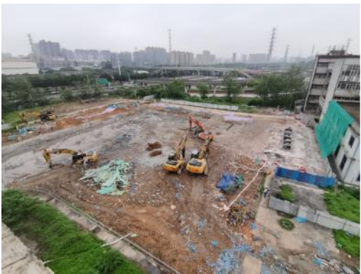
新建 220kV 变电站站址处
