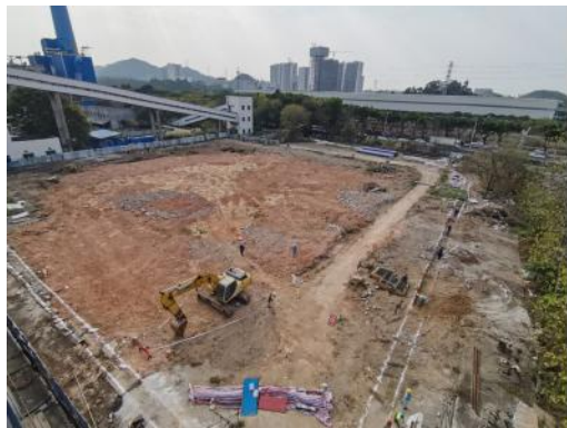
新建 220kV 变电站站址处
