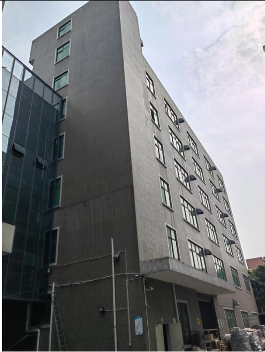
项目南面：园区 4 栋工业厂房
