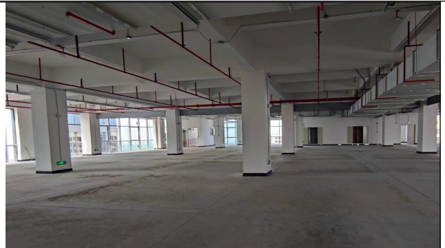
建设项目 4 栋 401 车间
