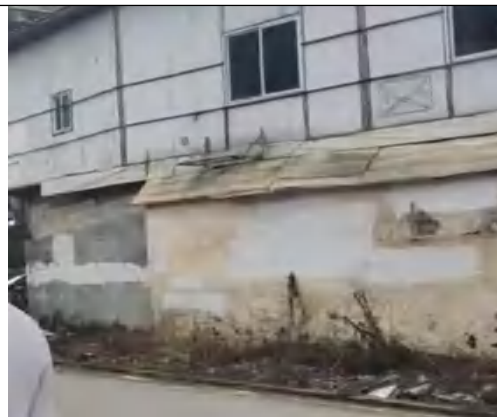
东南面—空置厂房
