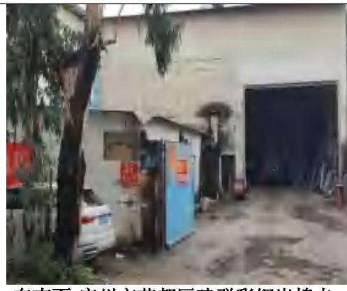
东南面-广州市花都区建群彩钢岩棉夹芯板厂
