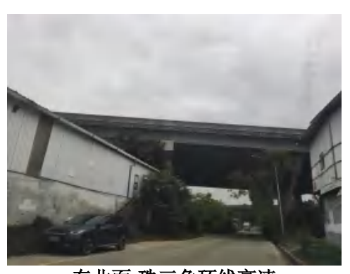
东北面-珠三角环线高速
