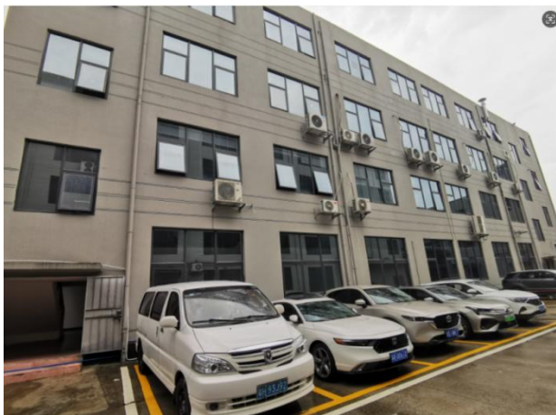
项目东南面-园区办公楼
