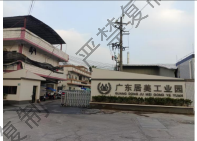
项目北侧-广东居美工业园
