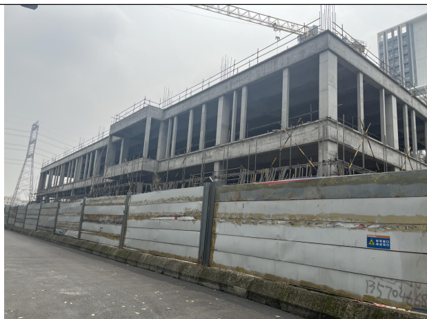
项目南面为园区在建厂房
