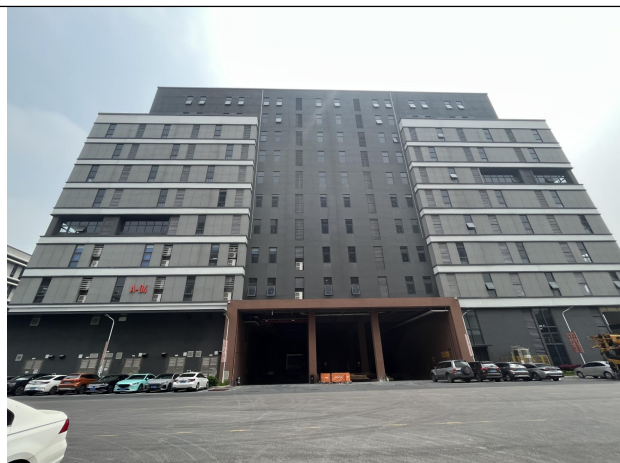
项目东面为园区 A4 栋厂房
