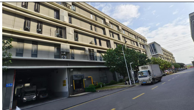
项目北面为园区 A1 栋厂房
