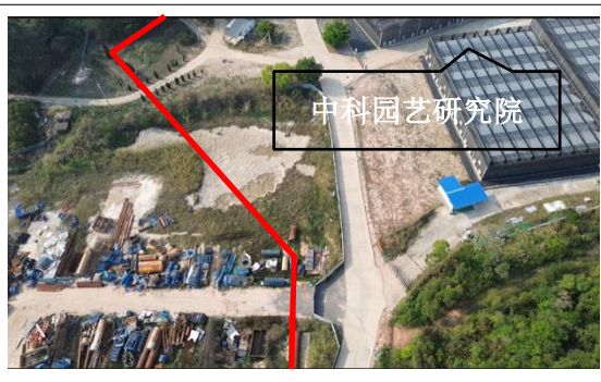
途经现状车行道现场航拍照片1
