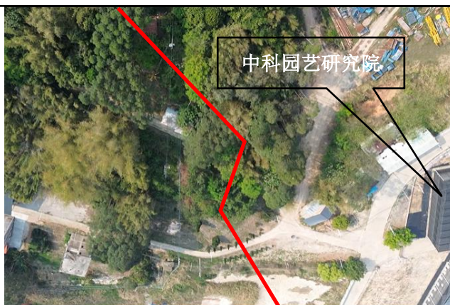
途经现状车行道现场航拍照片2
