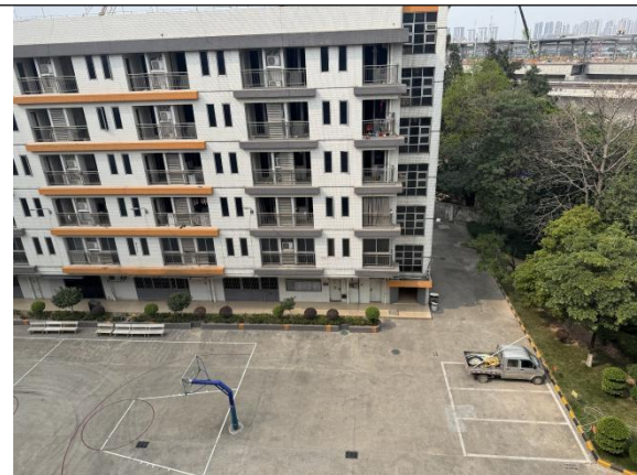
项目北面-空地及其他工业厂房
