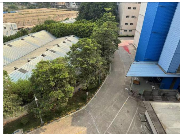
项目南面-空地及其他工业厂房
