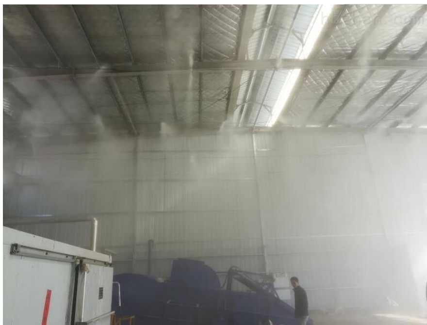
图 4-7 空间雾化除臭系统参照图
