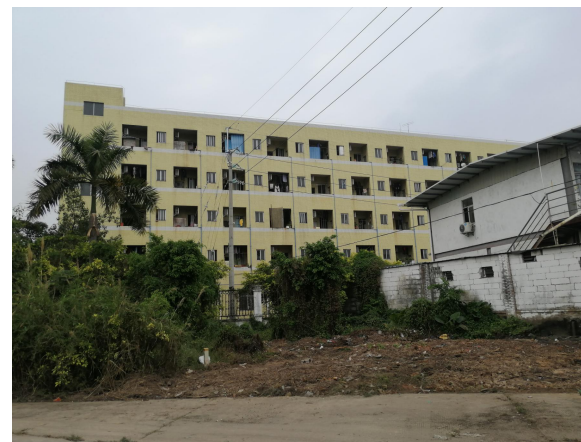
项目北面--广州市南粤钢管有限公司
