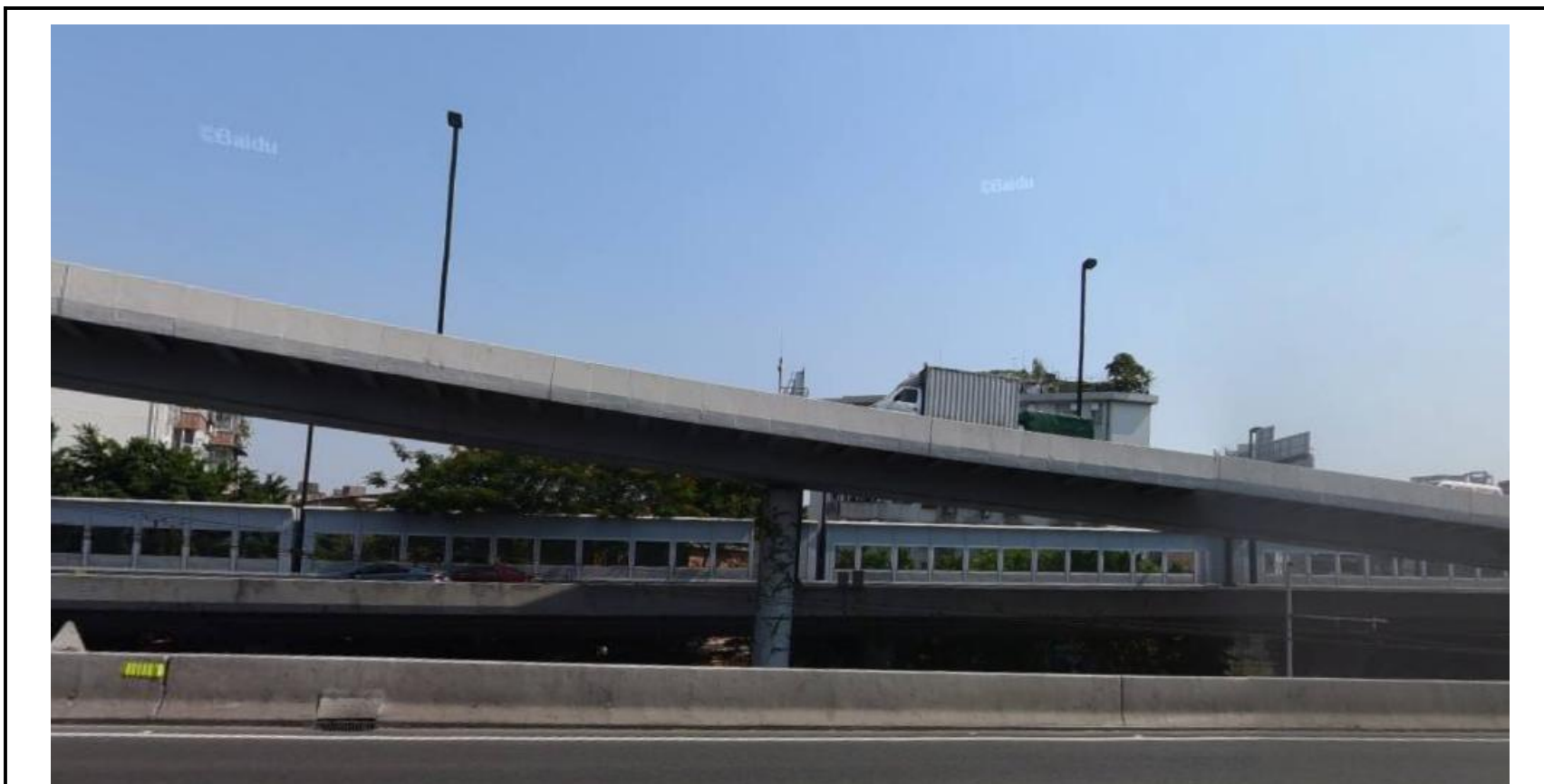
东面-高架桥梁
