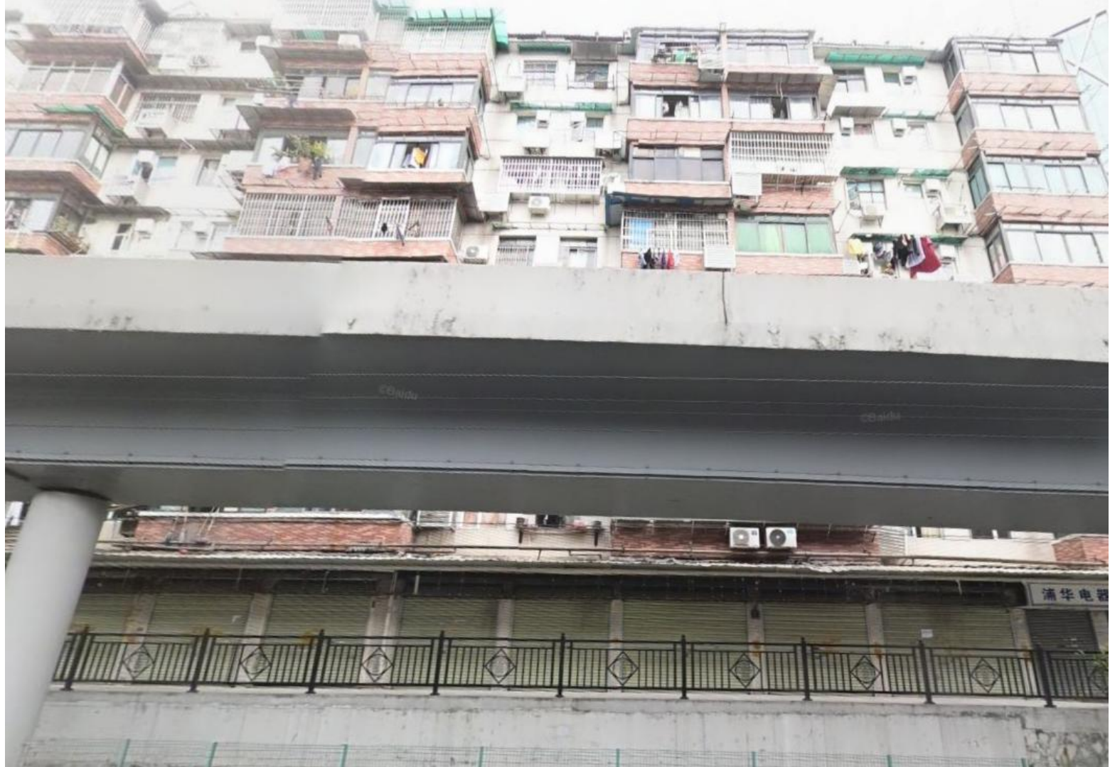
北面-已建建筑及道路桥梁
