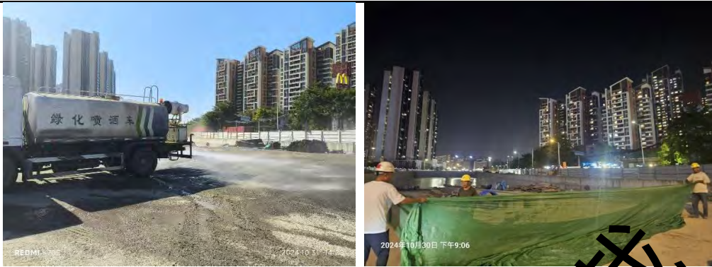
图 5-1 施工期大气污染防治措施照片
