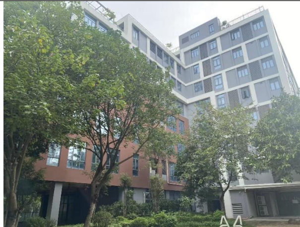
项目北面清华科技园 A3 栋厂房
