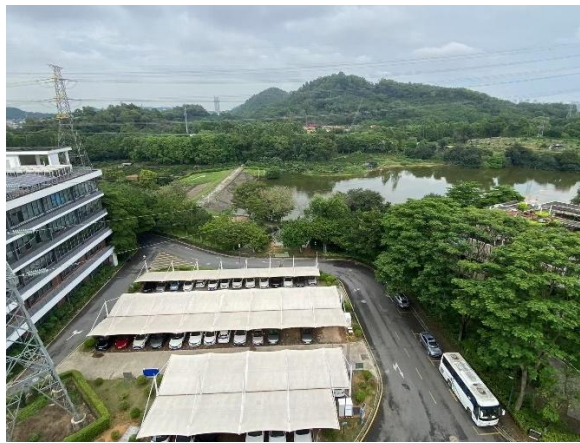
项目东面：停车场
