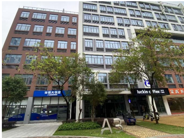
项目西面：清华科技园 A4 栋厂房
