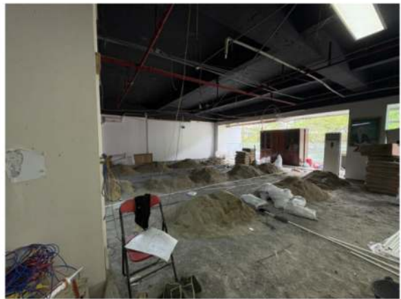
项目建筑内部情况
