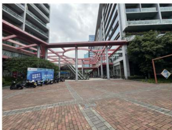
项目北面 番禺节能科技园科技产业大厦 2 座
