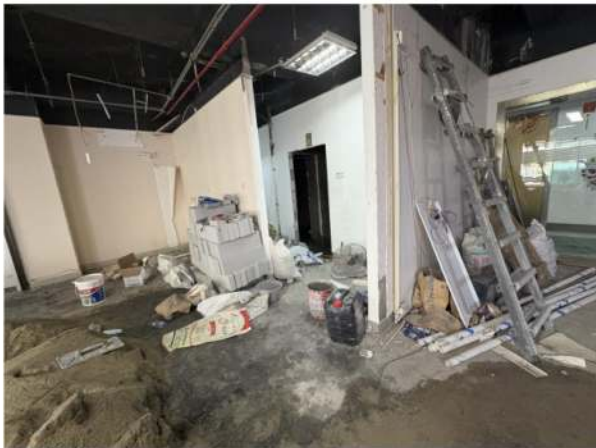
项目建筑内部情况
