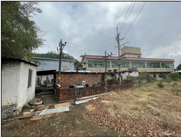
项目西侧-空地
