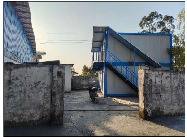
项目西北侧-通道、其他企业的食堂
