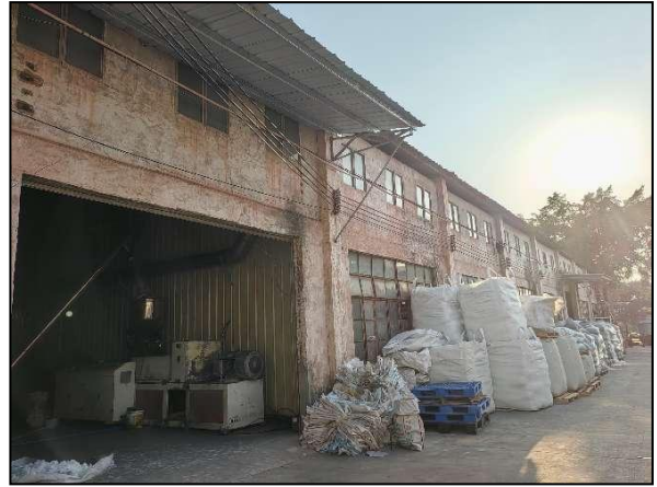
项目南侧-广州市弘盛新型材料有限公司
