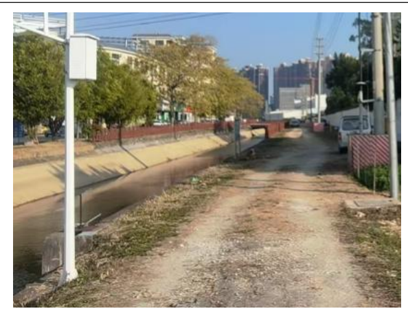
北面-流溪河灌区右总干渠
