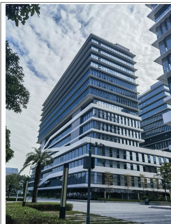
东：摩天工坊 4 号楼
