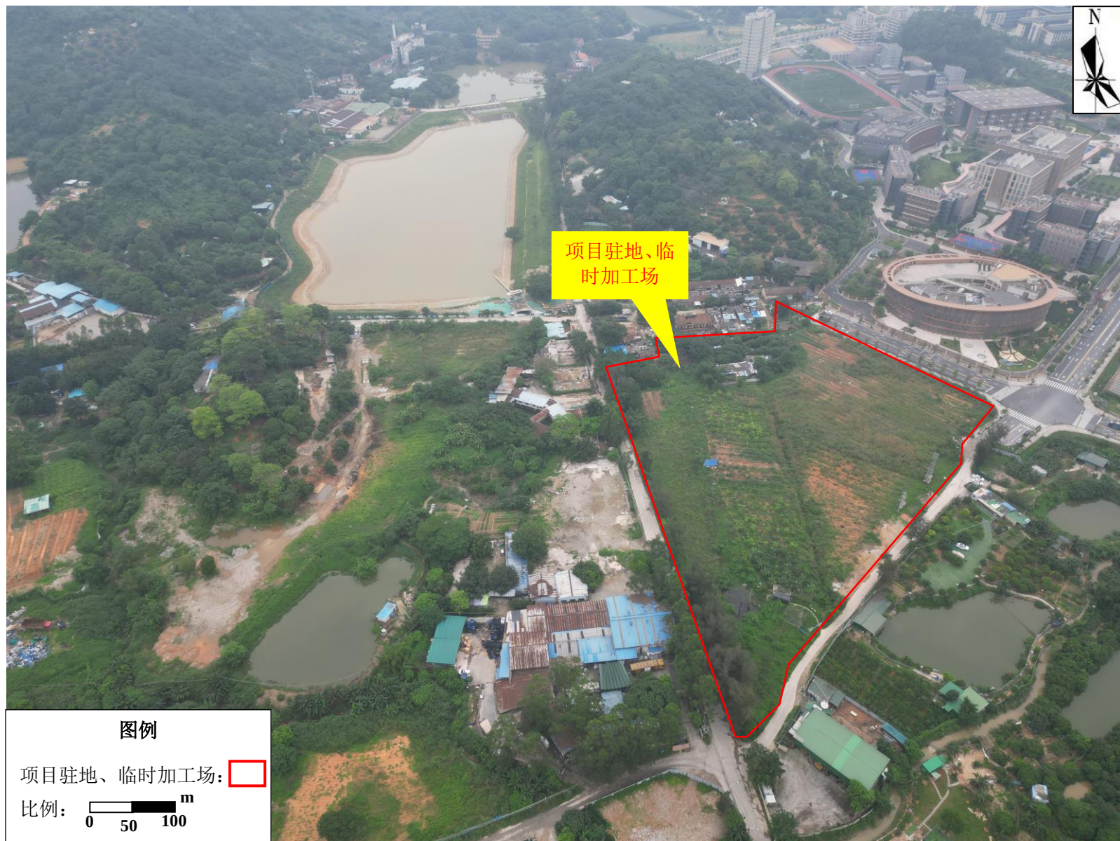
图 3.2-5 项目驻地、临时加工场现状图
