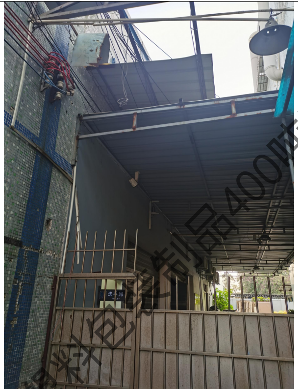
南侧华科木制品厂厂房
