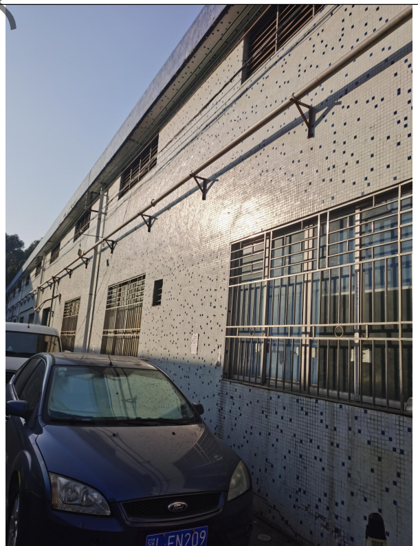
北侧瑞帆金属公司厂房
