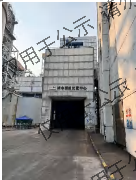
干污泥卸储料一体仓
