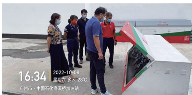
检查加油站油气治理情况
