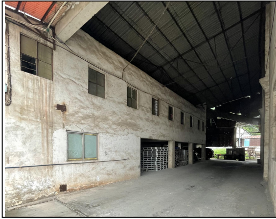
项目南侧-通道、仓库
