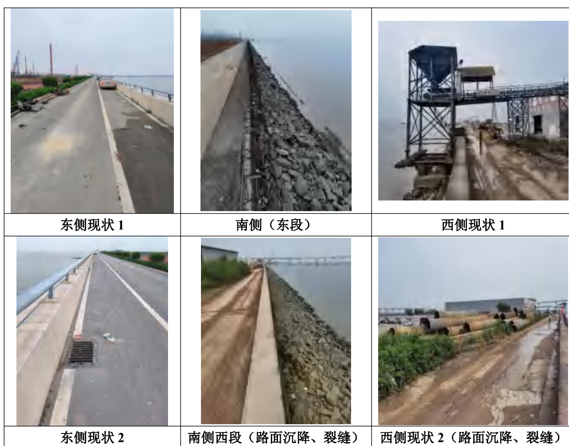
图 3.1.4-1 二十一涌以南堤防现状
