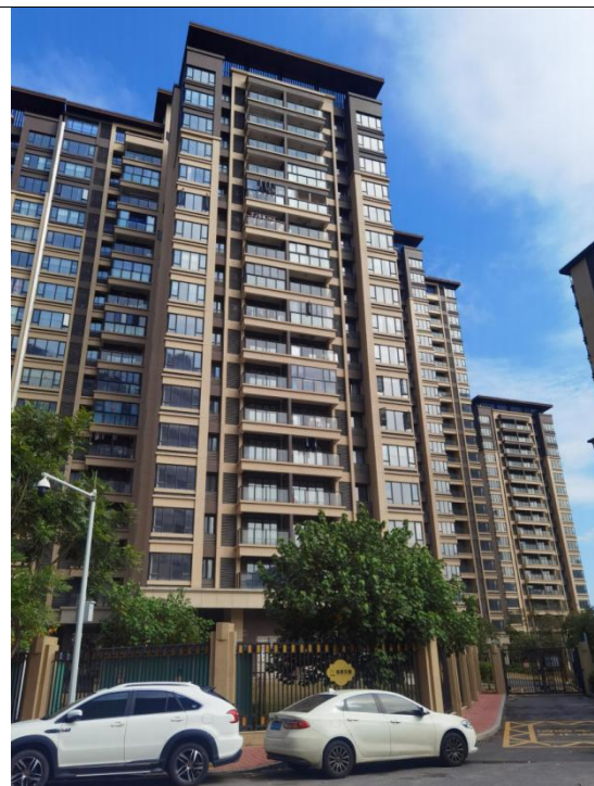
东北面：首筑花园
