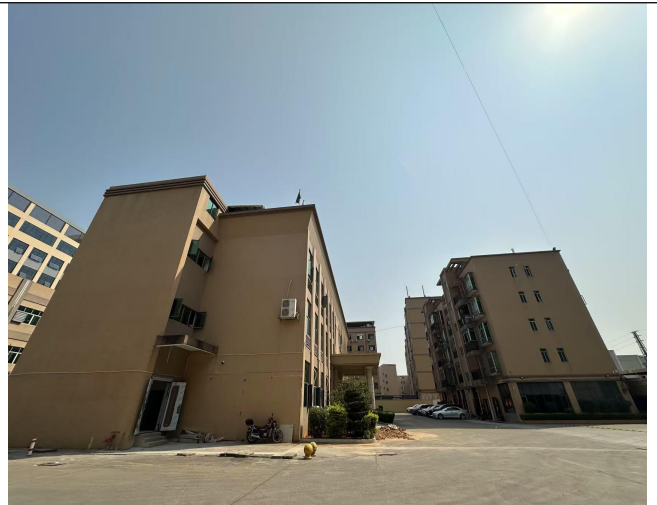
项目东面—园区办公室
