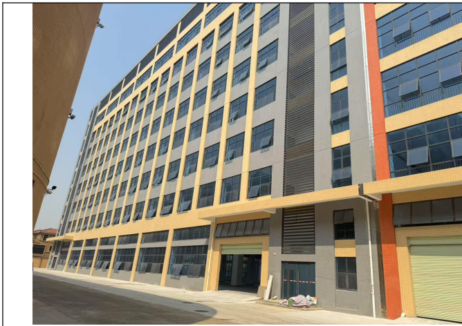
项目北面—空厂房
