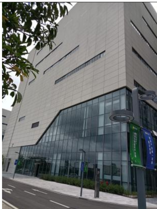
1#东北面为 3#栋厂房
