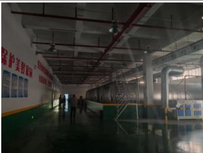
项目厂房情况-通道
