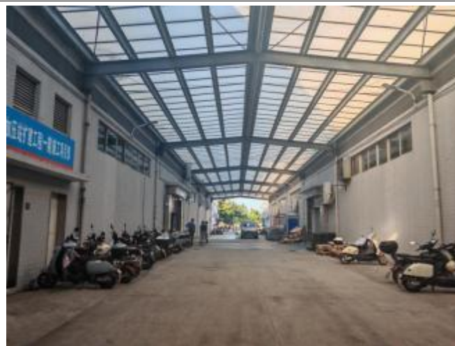
项目厂房情况-卸货区
