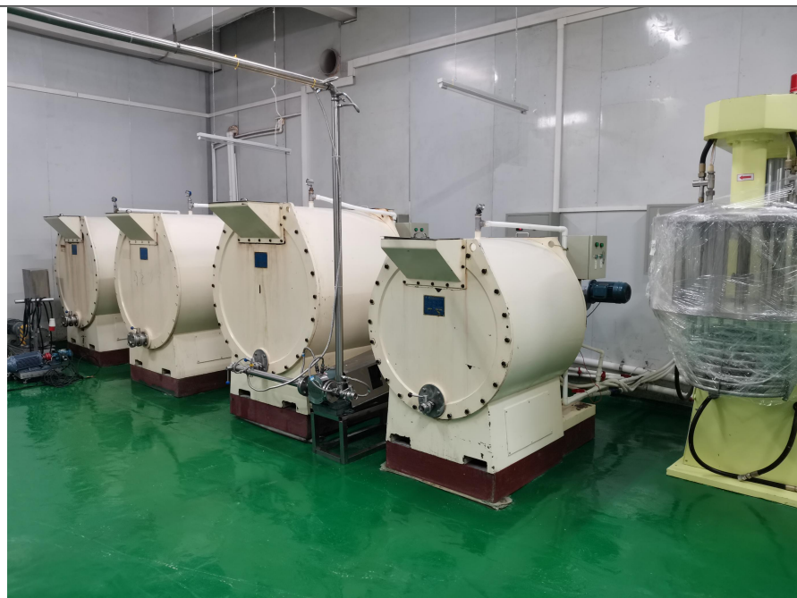
搬迁前项目现状照片
