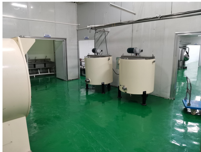
搬迁前项目现状照片
