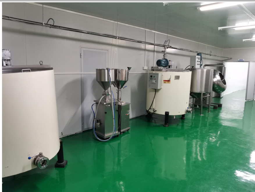
搬迁前项目现状照片
