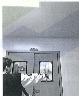
厂房内车间门外 1 米处 5#
