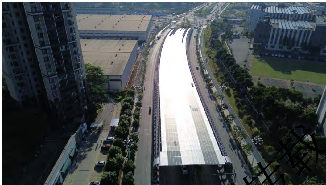
图 6.2-2 某项目已建全封闭隔音屏光反射航拍照片
