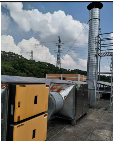
图 2-5 防锈、切削工序产生有机废气处理设施（油气回收器+活性炭+15 米排气筒 DA001）现场图
