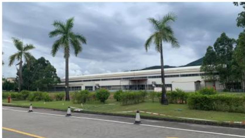
西面：广州金邦有色金属有限公司厂房
