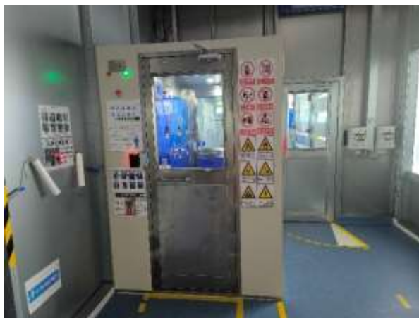
图 4.4-5 涂装车间收集措施现场照片
