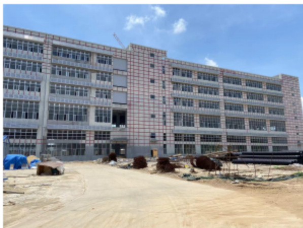
厂区现状（正在施工的1#厂房）
