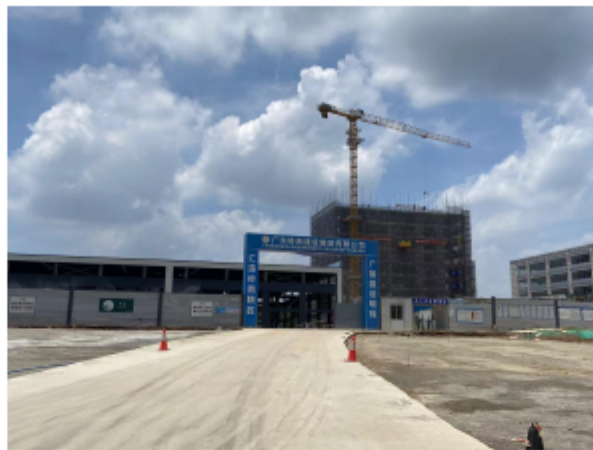
厂区东南面（在建厂房）
