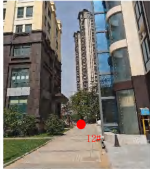
1号楼和2号楼之间室外通道
