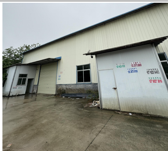
北面（邻厂空仓库）
