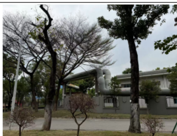
项目西北面 西区水质净化厂
