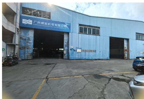
项目西面 广州威能机电有限公司
