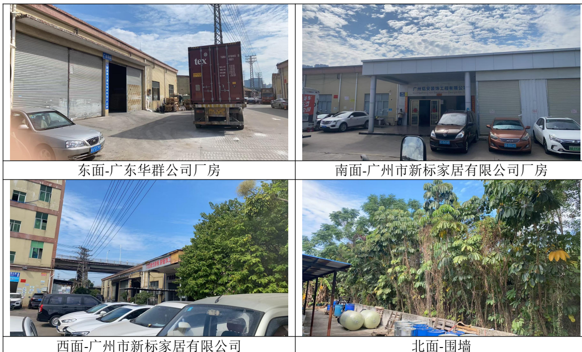
附图 9 项目现场照片
