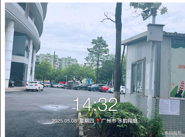
水韵翔庭现场公示图片（远照）2025.5.8
