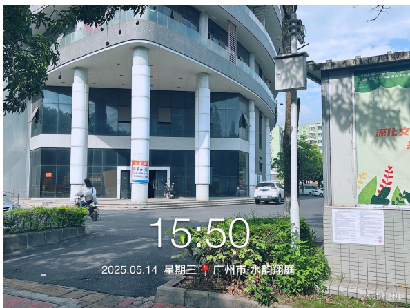
水韵翔庭现场公示图片（远照）2025.5.14
