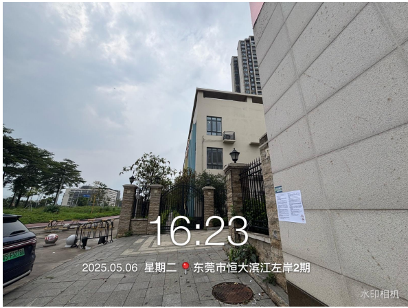
恒大滨江左岸现场公示图片（远照）2025.5.6
