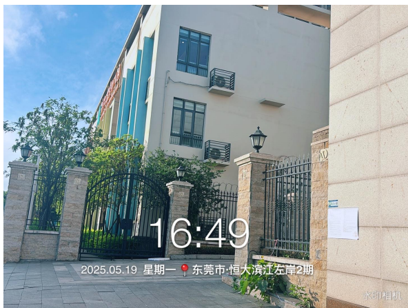
恒大滨江左岸现场公示图片（远照）2025.5.19
