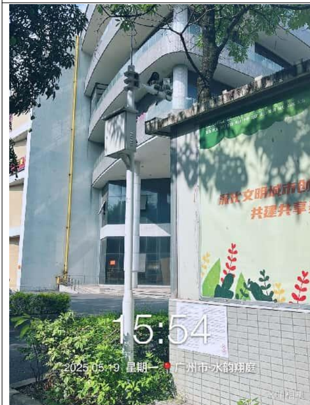
水韵翔庭现场公示图片（远照）2025.5.19
