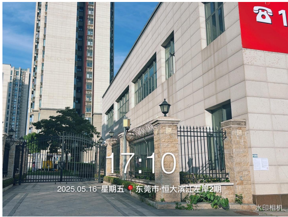
恒大滨江左岸现场公示图片（远照）2025.5.16
