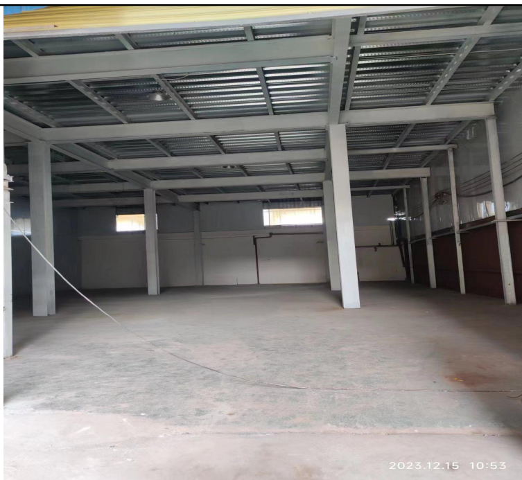
图3-1 项目厂房现状地面硬化情况照片图
