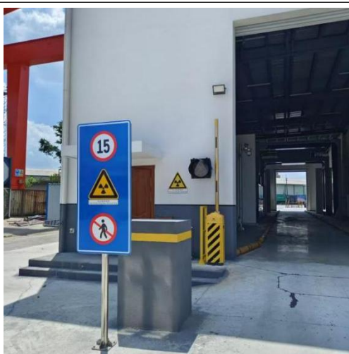
入口处：电离辐射警告标志、限速标识
