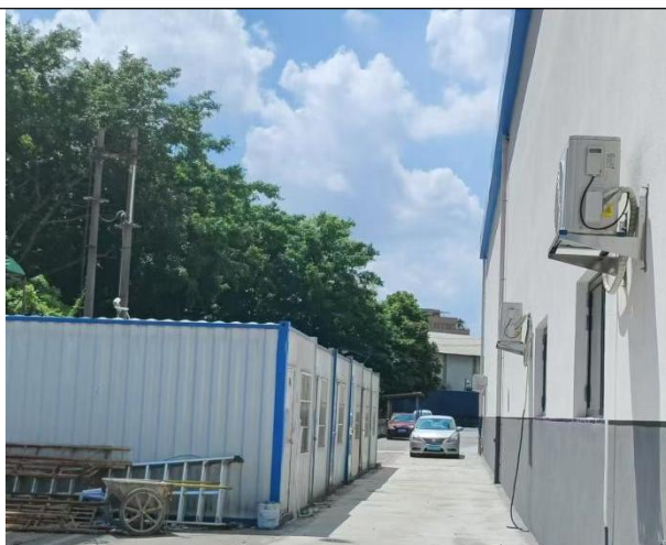
板房（宿舍）现状
