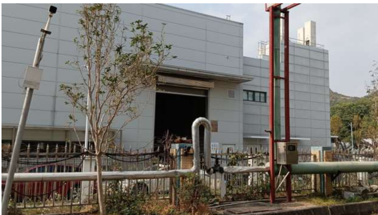
项目北面-广州西门子能源变压器有限公司
