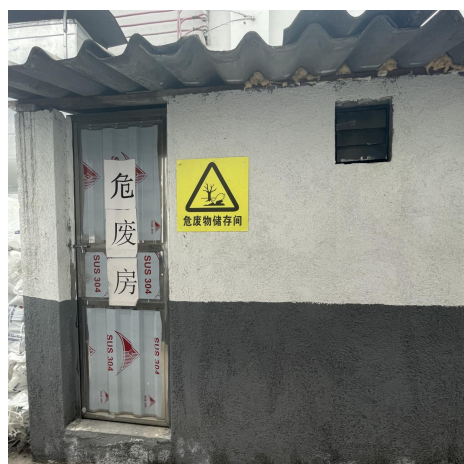
危废房（整改前）
